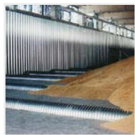
Canali di ventilazione Ventilation ducts
