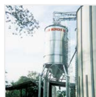
Silos di carico rapido Loading bins
